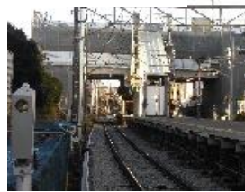
平瀬第2踏切側
